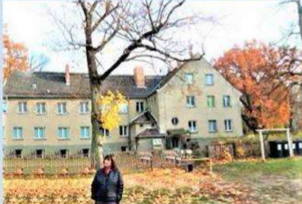
נוינדורף - בניין המינהלה של "הכשרת נוינדורף" בעמוד לבניין בחזית הבאר ההיסטורית מן השנים 1941-43. נאווה גד בביקור ב-2018 Neuendorf - the central building of the "Hachshara" with the historic well. Nava Gad during visit in 2018.
