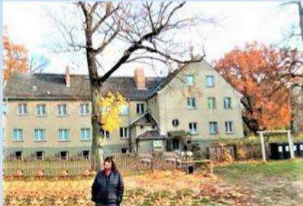
נוינדורף - בניין המינהלה של 'הכשרת נוינדורף' בעמוד לבניין בחזית הבאר ההיסטורית מן השנים 1941-1943. נאווה גד בביקור ב-2018 Neuendorf - the central building of the "Hachshara" with the historic well. Nava Gad during visit in 2018.
